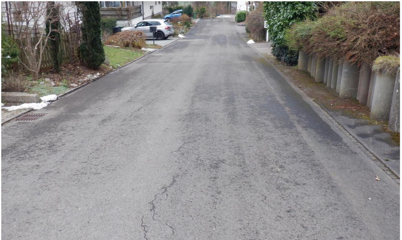
*Abbildung 2: Zustand Strassenbelag mit feinen Rissen*
