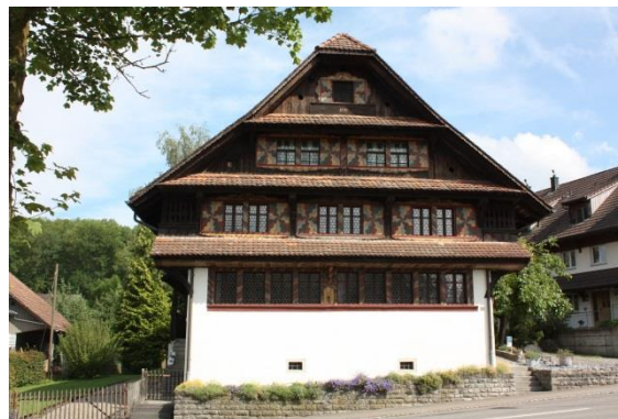
Denkmalgeschütztes Koch-Haus, Baujahr 1791; Liegenschaft Sarmenstorfstrasse 9
